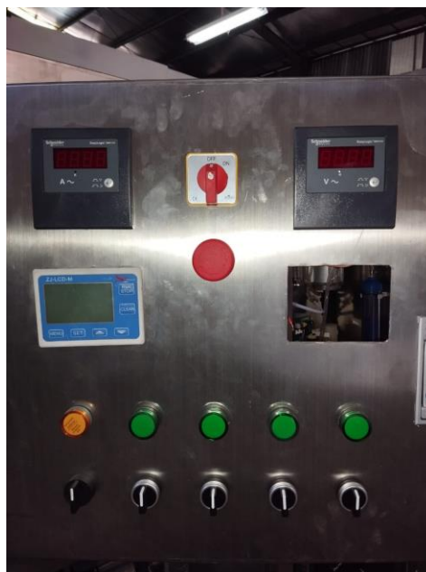
Gambar 4. Kontrol mesin IPAL manual
